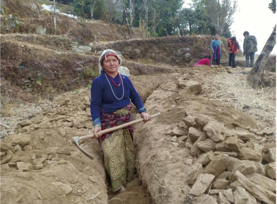
水道のパイプを通すための溝を掘っている様子
