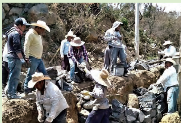
生産者の共同作業による歩道づくり
