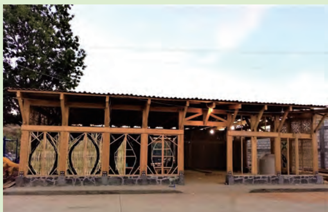
建設中の市場。ここではメキシコの国家的植林プロジェクト「センブランド・ヴィダ」によって生産された商品も販売される予定だ。
