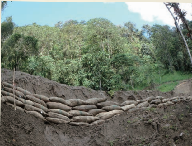
▲ 森の一部が伐採され、平地になった場所。土砂崩れを防ぐため土嚢が積まれている。
